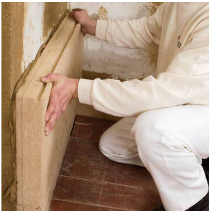
Kontaktschluss durch Eindrücken in den plastischen Mörtel
