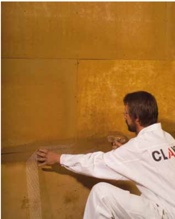
Abbildung 5.2.6: Einarbeiten der Fugenarmierung, mit sorg- fältiger Bearbeitung der Randbereiche
